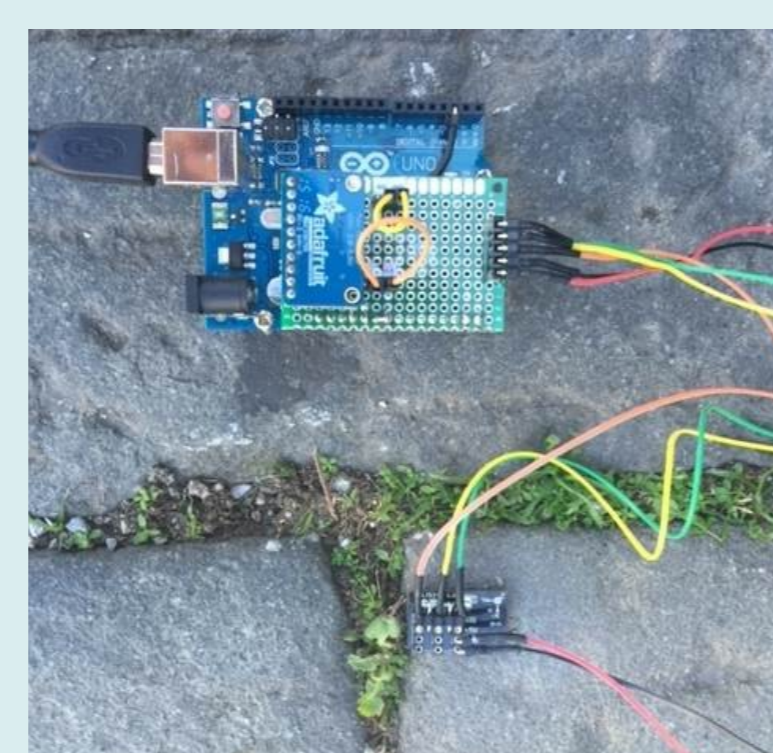
Applicazione del sistema all'impalcato del ponte
