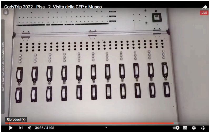
In figura una parte degli strumenti di controllo tensioni e correnti
