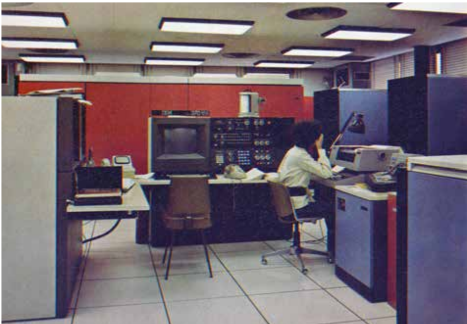
Altro scorcio della sala macchina del CNUCE
